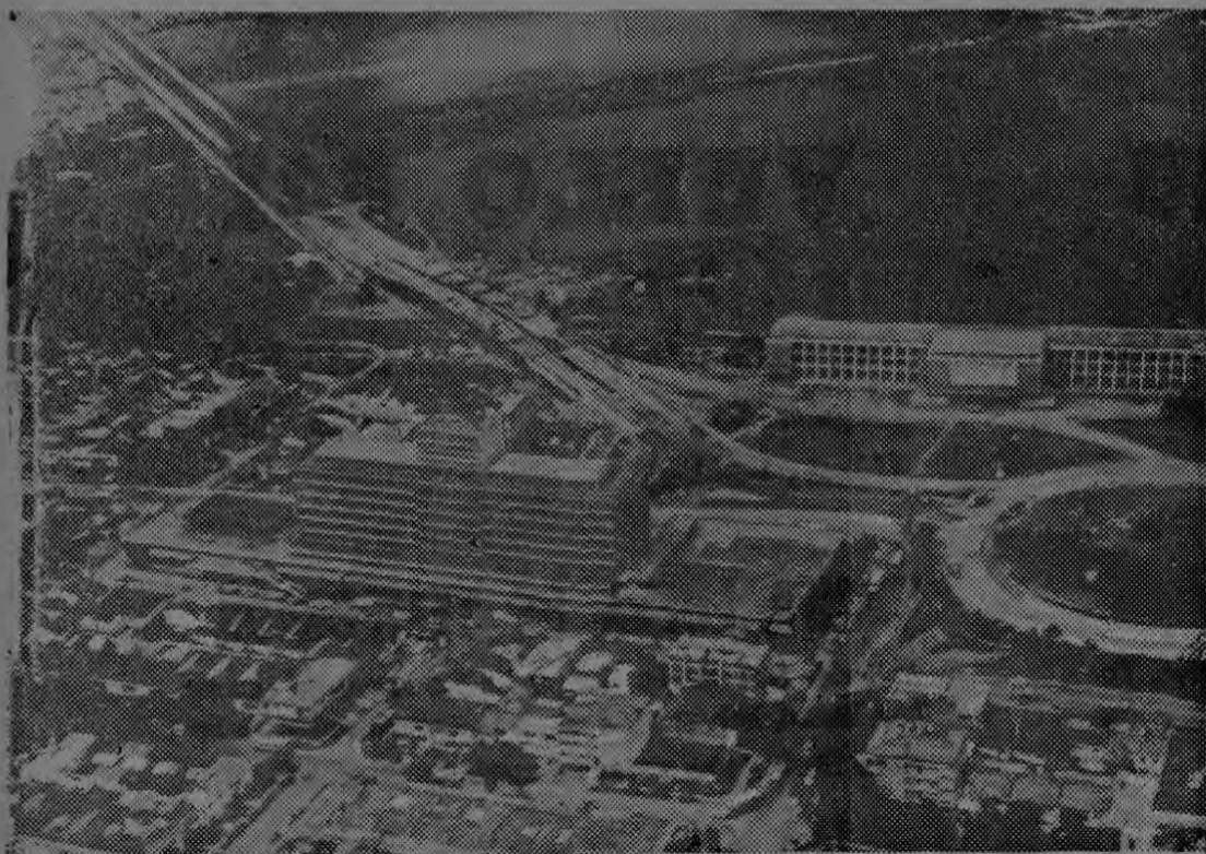
NUEVAS VIAS DE COMUNICACION: — Modernas y amplias avenidas se construyen en Cali en preparación para los VI Juegos Panamericanos del próximo año. La fotografía aérea, muestra un paso elevado que se está terminan-
